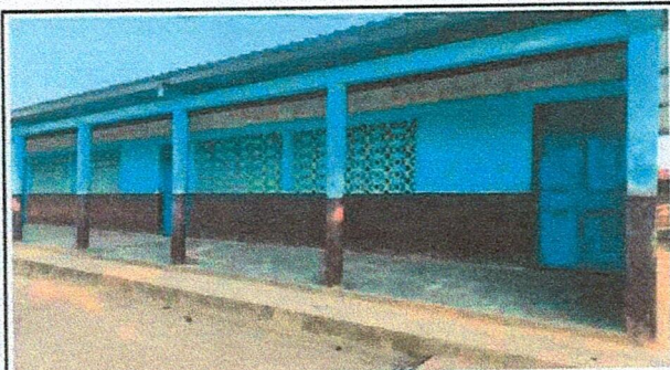
instalacion de Valcones de metal en modulo de escuela
