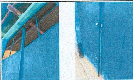
Reparacion de puertas por deterioro y mal estado de las mismas
